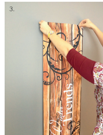
3. „Haftfabric“ positionieren und fixieren
