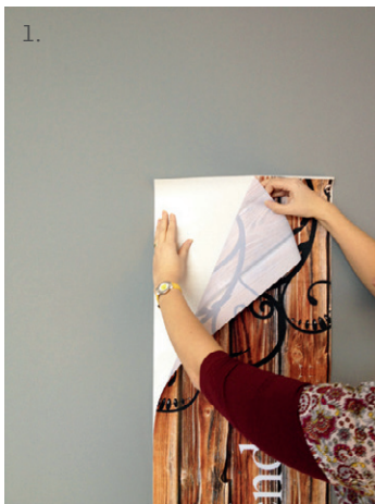
1. Das „Haftfabric“ vom Trägerpapier entfernen
